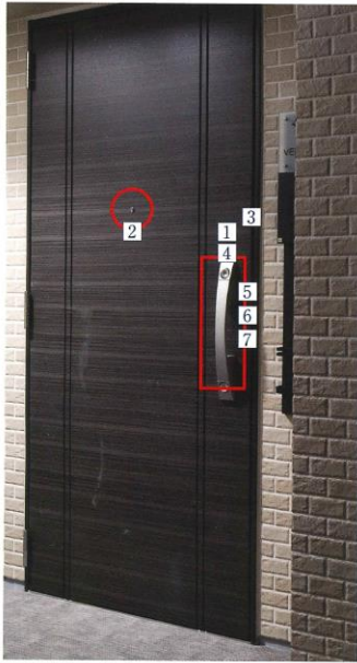
※写真は備品の一部。すべて参考写真です。
