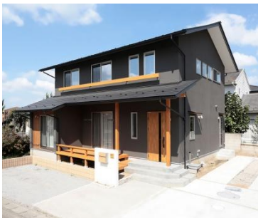
齊藤林業 施工事例
