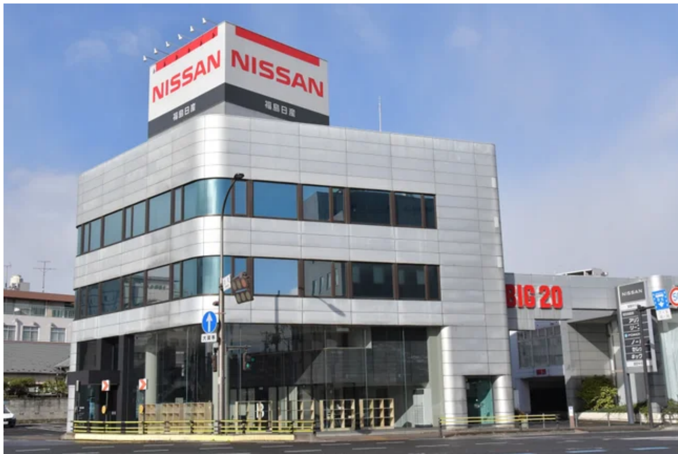
改装工事を終えた福島日産 本店
