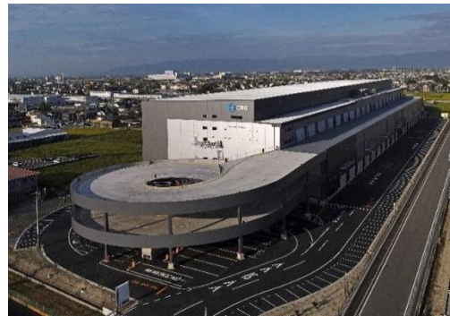
26 ロジスクエア一宮 2023年9月竣工
