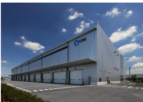
15 ロジスクエア川越Ⅱ 2019年6月竣工
