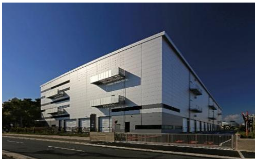
21 ロジスクエア伊丹 2022年11月竣工
