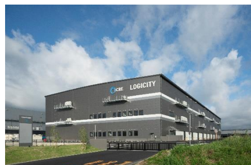
32 ロジシティ小郡 2024年7月竣工
