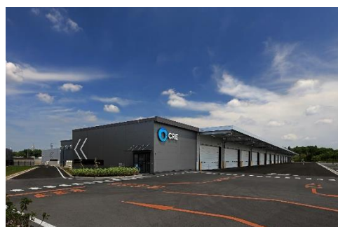
31 ロジスクエア成田 2024年5月竣工
