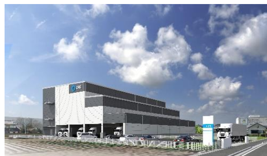
40 ロジスクエア久喜Ⅲ 竣工時期未定
