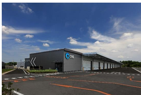
31 ロジスクエア成田 2024年5月竣工
