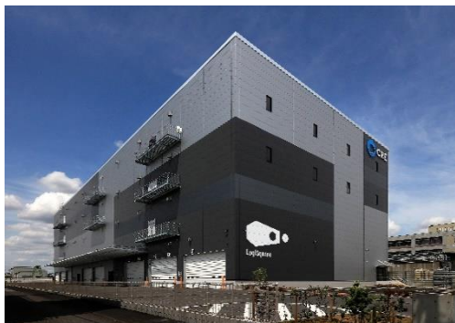
25 ロジスクエア松戸 2023年5月竣工
