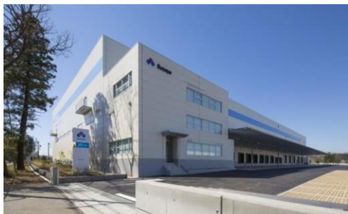
3 ロジスクエア日高 2015年3月竣工
