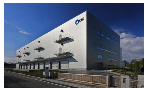
8 ロジスクエア新座 2017年4月竣工
