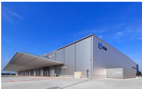
5 ロジスクエア羽生 2016年7月竣工
