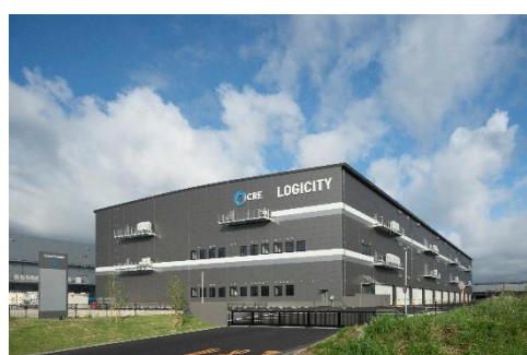
32 ロジシティ小郡 2024年7月竣工
