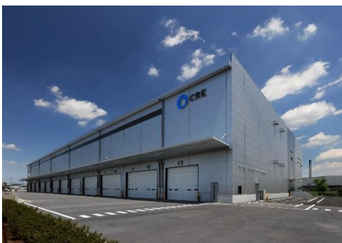
15 ロジスクエア川越Ⅱ 2019年6月竣工
