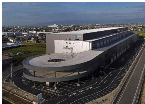
26 ロジスクエア一宮 2023年9月竣工
