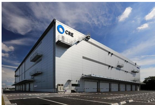
13 ロジスクエア春日部 2018年6月竣工
