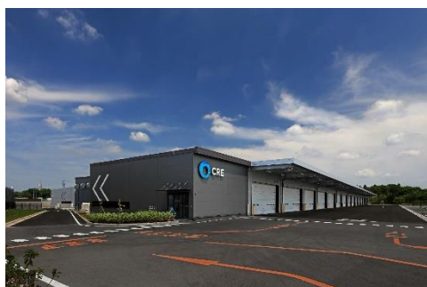
31 ロジスクエア成田 2024年5月竣工
