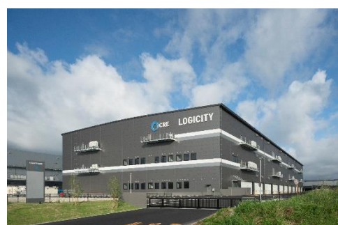
32 ロジシティ小郡 2024年7月竣工
