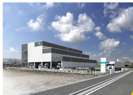
40 ロジスクエア久喜Ⅲ 竣工時期未定
