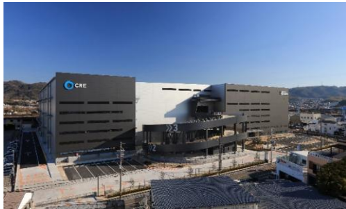
19 ロジスクエア大阪交野 2021年1月竣工
