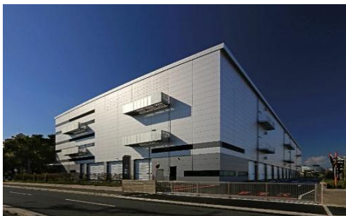
21 ロジスクエア伊丹 2022年11月竣工
