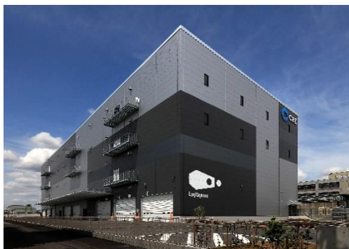
25 ロジスクエア松戸 2023年5月竣工
