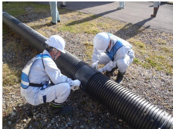
実地訓練(仮設配管接続)
