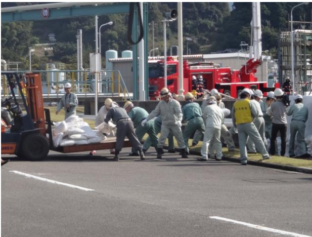
土のうの構築
