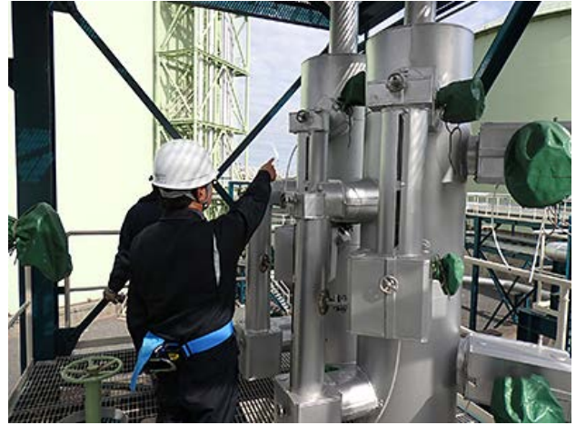
配管満液確認
