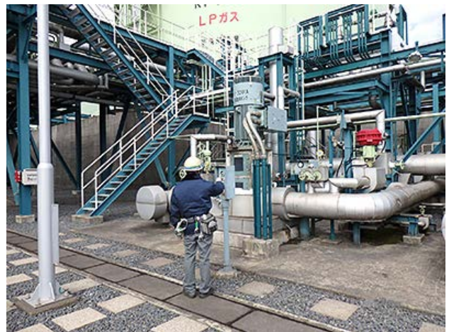
ポンプ起動確認
