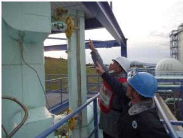
配管満液確認
