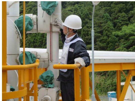
満液状態確認作業
