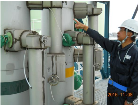
配管満液確認
