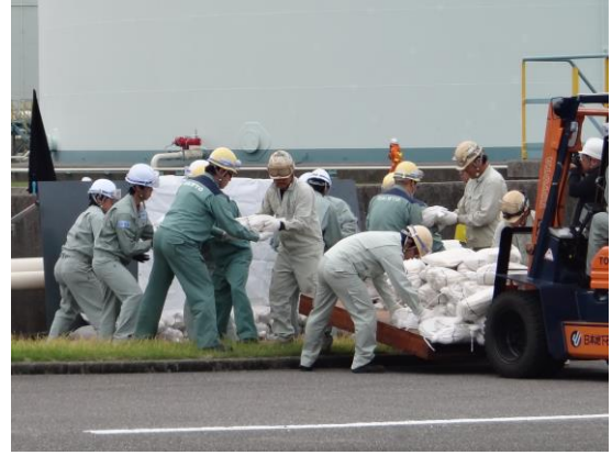
防油堤亀裂箇所への土のう構築
