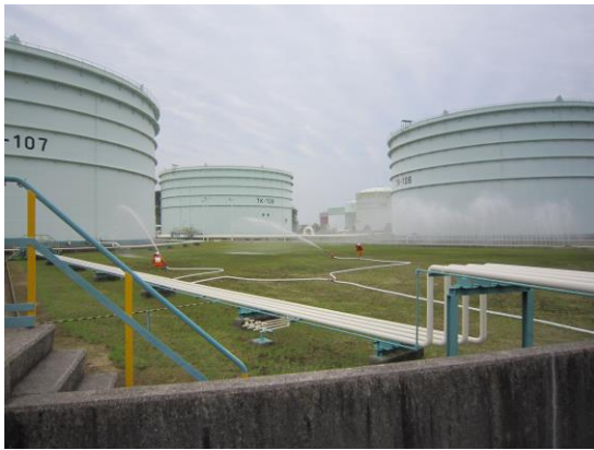
原油タンクへの放水銃と水幕ホースによる冷却散水
