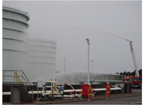
発災タンクへの泡消火活動
