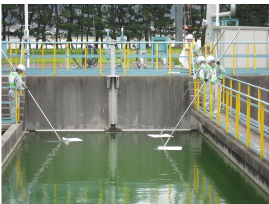
ガードベースンでの流出油の回収
