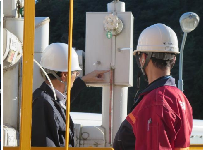
隣接基地との境界配管満液確認
