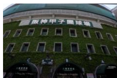
2007年から3年をかけて大幅改修を実施
