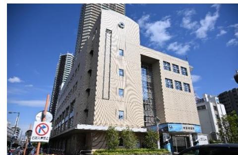
中原区役所【中原区】 1階を木質化リノベーション
