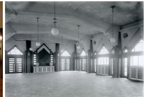
銀座クラシックホール・竣工当時
