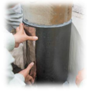
<防蝕テープ仕上げ>
