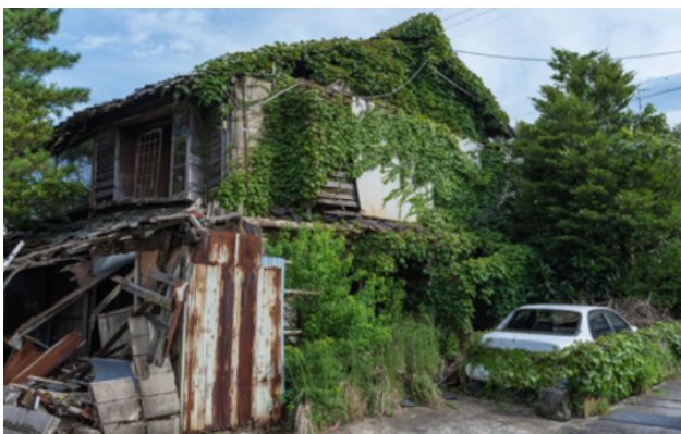
廃墟のようなボロ戸建
