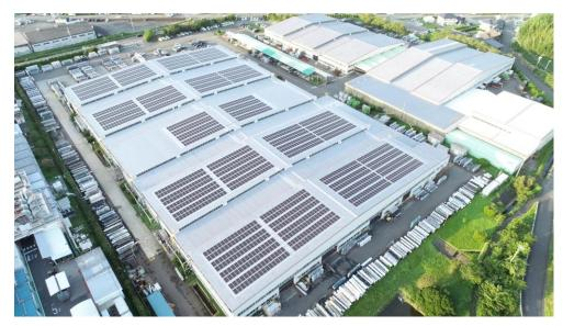
このたび、静岡工場に設置した太陽光発電設備は、パネルの総面積が約 4,500 ㎡で、約 1,014kW(キロワット) の発電能力を有します。静岡工場で使用する電力の約 44%をまかなう予定で、年間約 340 トンの  $CO_2$  排出量削減を見込んでいます。
