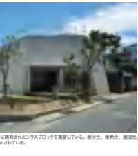
「SHIRASU」。この建築のために開発されたシラスブロックを積んでいる。耐火性、断熱性、透水性、弾力性、軽さなどの利点がある。
