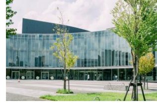
プラザノース 写真/PIXTA 図書館、区役所、ホール、アトリエ、多目的ルーム、セミナールームなどの複合型施設
