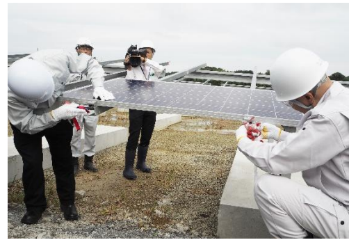
取付金具のボルト締め太陽光パネルを架台に固定
