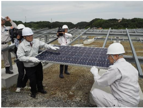
太陽光パネルを架台に設置
