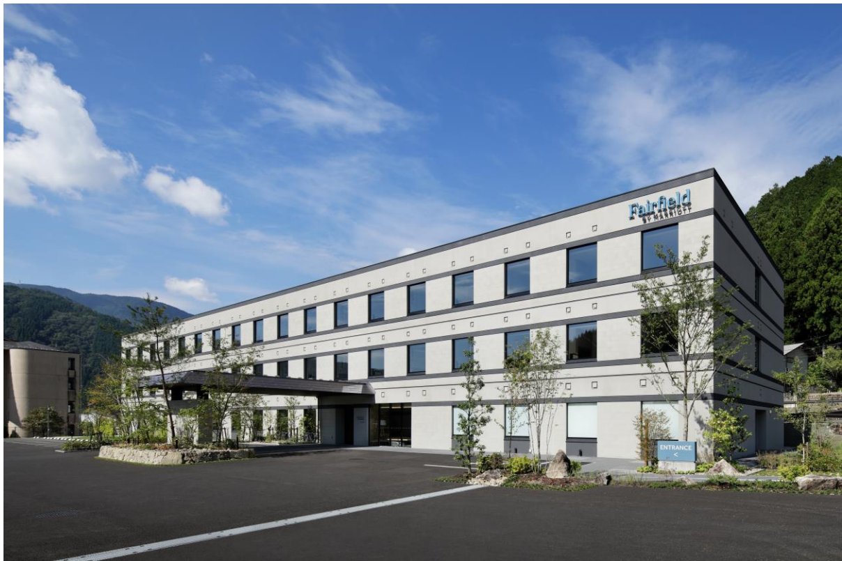
外観：フェアフィールド・バイ・マリオット・岐阜郡上
