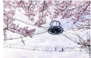
絶叫吊り橋「風天」
