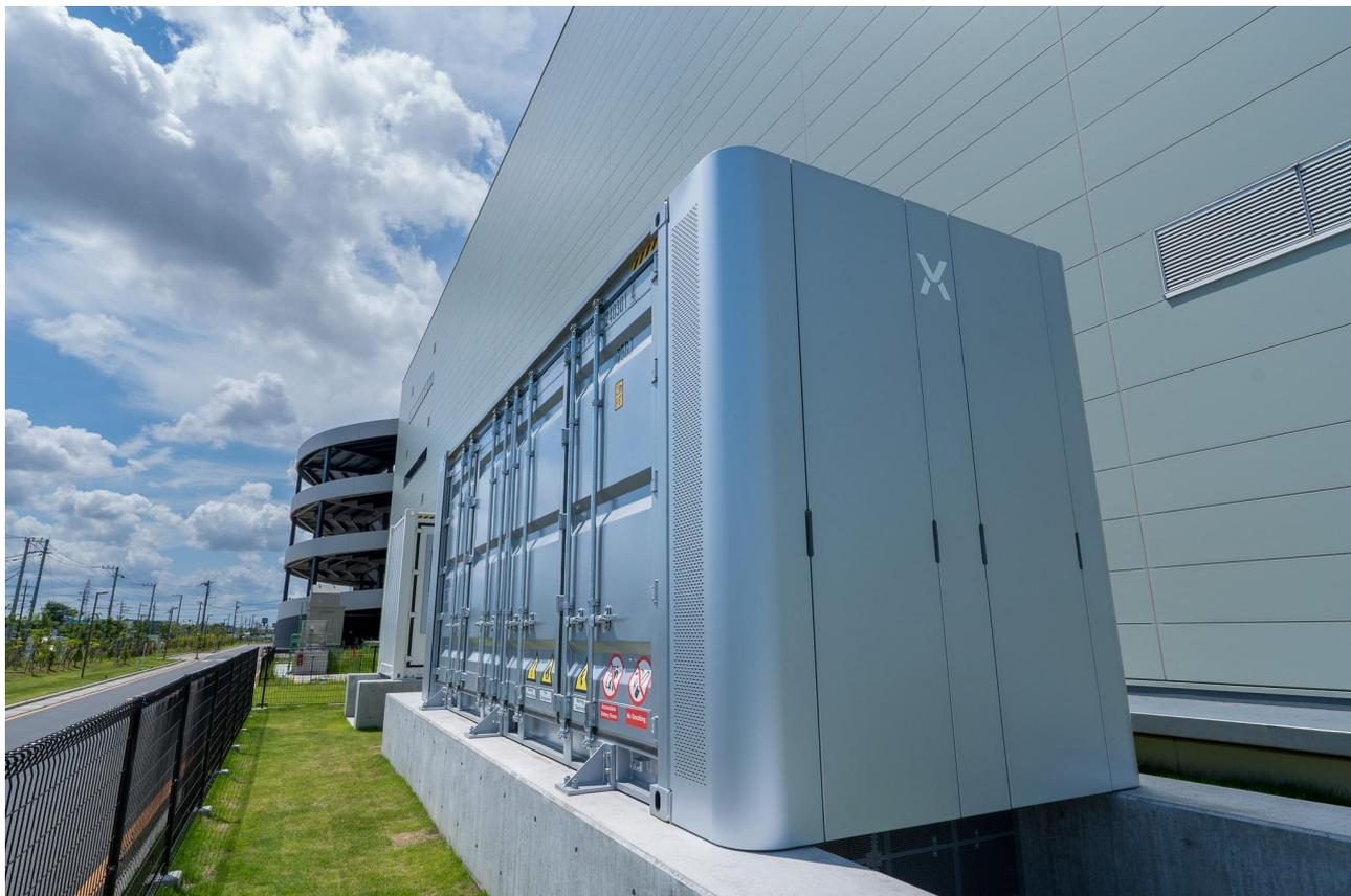
今回設置されたコンテナ型定置用蓄電池およびエネルギー管理システム（EMS）は、蓄電池の最適な充放電制御を可能にし、ピークシフト・カットによって施設全体のエネルギー効率を向上させます。また、再生可能エネルギーの有効活用を促進し、施設の電力コスト削減に貢献するほか、環境負荷の軽減にも寄与します。
