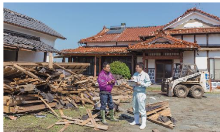
損害調査の様子
