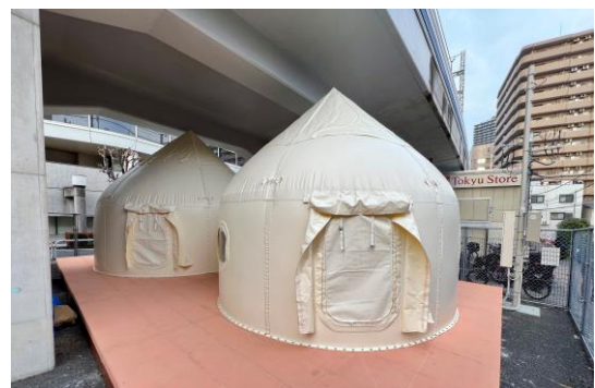
▲現地工事の様子
