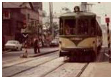
▲東急線で使用していた様子(敷石)
