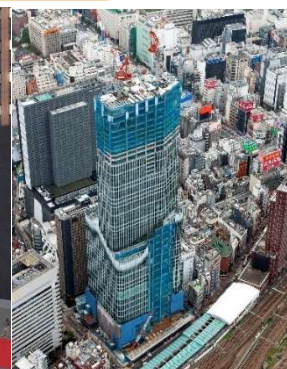
▲工事進捗状況
