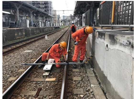
▲建築限界検査状況
