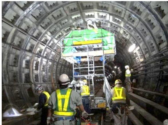
▲トンネル特別全般検査状況
