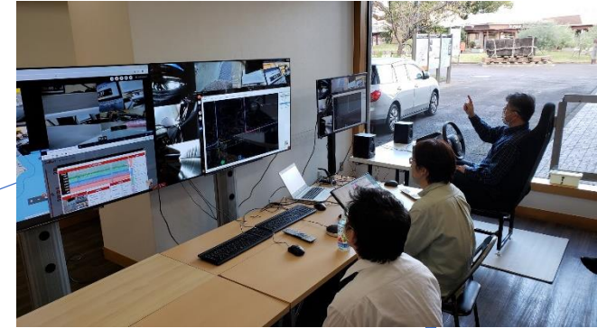
コントロールセンター（伊豆高原駅付近）
