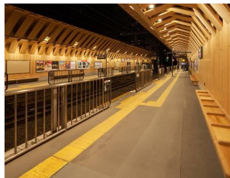
センサー付固定式ホーム柵
