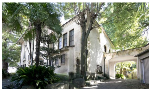
外観(改修工事前)
