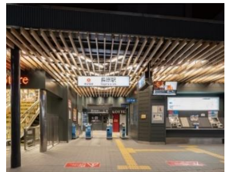
▲池上線長原駅(2021年度竣工)
