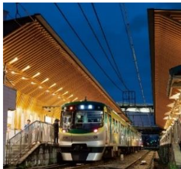
▲池上線旗の台駅(2019年度竣工)
