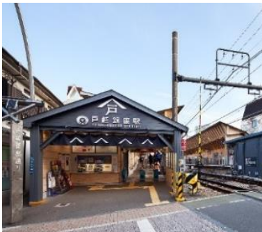
▲池上線戸越銀座駅(2016年度竣工)
