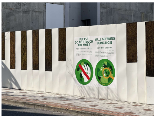
▲苔を使用した建設現場仮囲い全景
