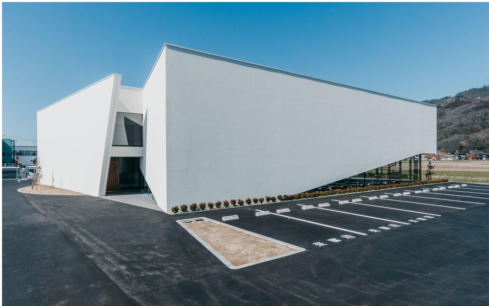
移転リニューアルしたe-Grid本社の新社屋外観
