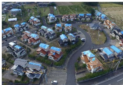
発災当時のブルーシート状況 (写真提供＝北栄町)
