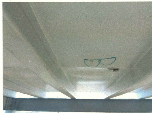
写真-4 デッキ下面
